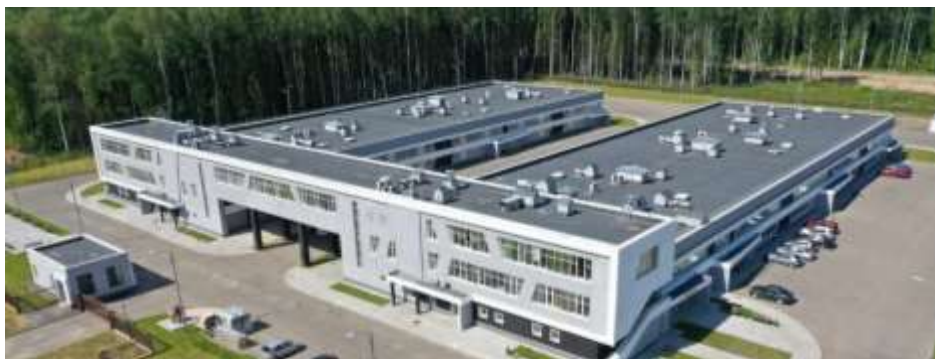
Производственно-лабораторный комплекс Правобережный участок (сдан в 2-м кв. 2019) Площадь: 9\,124 \text{ м}^2
