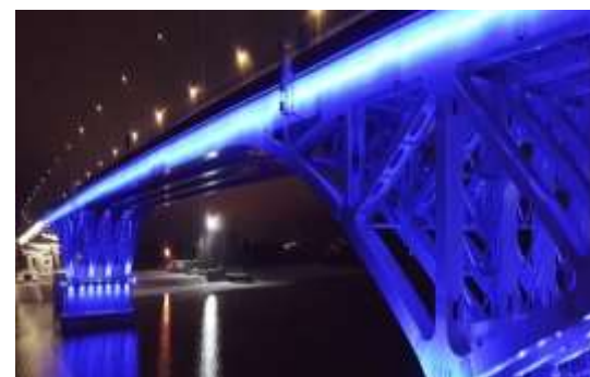
Мост через р. Волга
